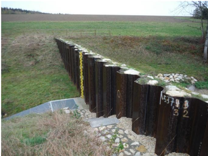
Abbildung 13: Vergleichsprojekt zur Veranschaulichung: Spundwand mit luftseitig stützendem Erdkörper, Dr. Ebel & Co. Ingenieurgesellschaft 2021
