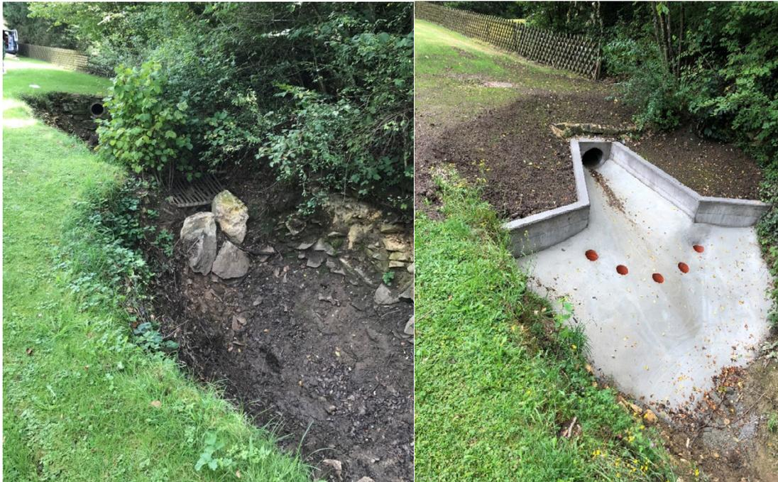
*Abbildung 4: Einlaufbauwerk Hüttenberg links: Altbestand vor 2018, rechts: Neu seit 2018 (noch ohne Pfahlrechen), Aufnahme Büro Kovacic*
