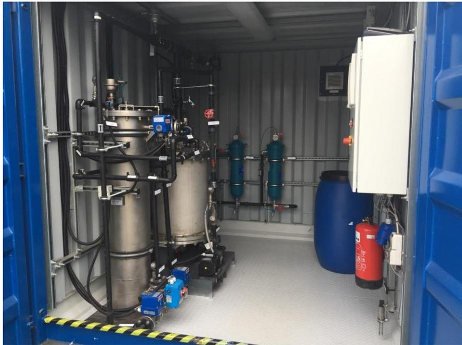
**Vortex-Filter (vollautomatisch rückspülbarer Feinfilter) in der Behandlungslinie mit PerfluorAd**
