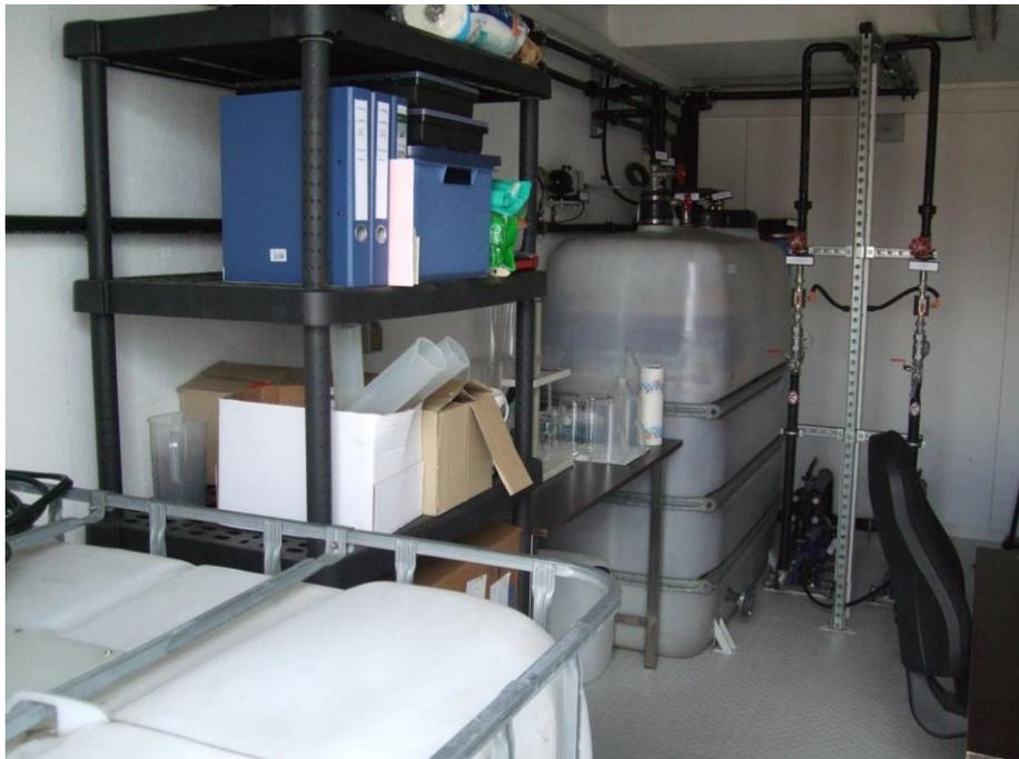
**Rohwasservorlage und -belüftung sowie Beschickungspumpen für die beiden parallel angeordneten Behandlungslinien**
