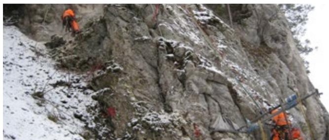
tals vorliegenden, ingenieurgeologischen Gutachten werden regelmäßig Felssicherungsarbeiten durchgeführt. Im Gebiet Maria-Trost bei Beuron wurden im Herbst 2017 die geplanten Einzelsicherungsmaßnahmen mit denen bereits im Herbst 2016 begonnen wurden, in einem zweiten Bauabschnitt fortgesetzt. Im Zuge dieser Arbeiten wurden punktuell Felsbereiche mittels insgesamt ca. 320 m<sup>2</sup> Stahlnetzen, ca. 80 m Seiltrossen und ca. 60 Felsnägel mit einer Gesamtlänge von rund 200 m gesichert.
